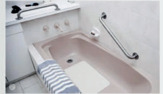
وضع الدعامات والأرضية الخشنة في الحمام لتقليل فرصة السقوط
